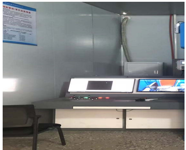
X射线检测系统控制台
